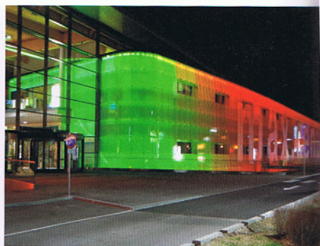
LED-Leuchten an der Ober- und Unterkante beleuchten die gesamte Fassade max.center in Wels
