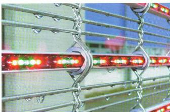
11 Die Unterkonstruktion aus Stahl nimmt bei »Mediamesh« erhebliche Spannkräfte auf und gewährleistet auch unter großen Windlasten eine verzerrfreie Bildwiedergabe. Die hohe Wetter- und Temperaturbeständigkeit (–20 °C bis +70 °C) sowie per Lichtsensor gesteuerte Helligkeit der LEDs, Nicht-Brennbarkeit, leichte Pflege, Recyclingfähigkeit und Robustheit sind weitere Qualitäten. (Foto: GKD – Gebr. Kufferath AG, Duren)
